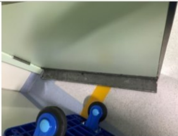
防护门下方设置的防泄露铅板
