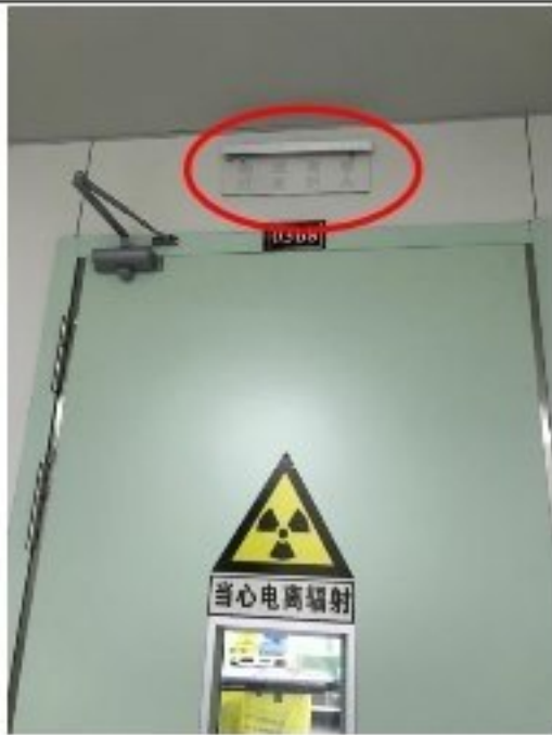
防护门 1 的工作状态指示灯和警告标识
