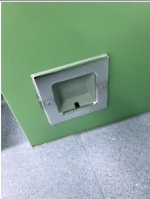
防护门 4（电动平开门）的脚触式感应开关
