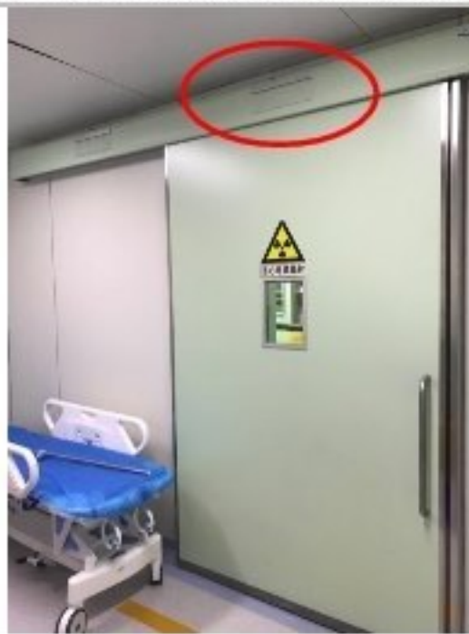
防护门 4 的工作状态指示灯和警告标识
