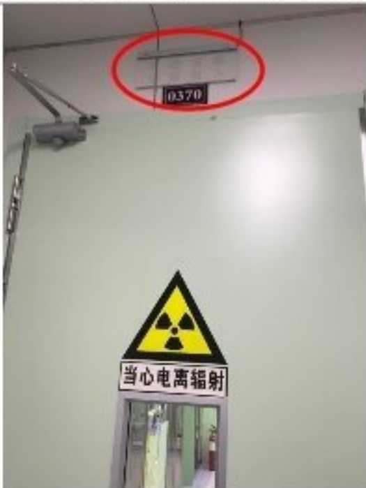
防护门 3 的工作状态指示灯和警告标识
