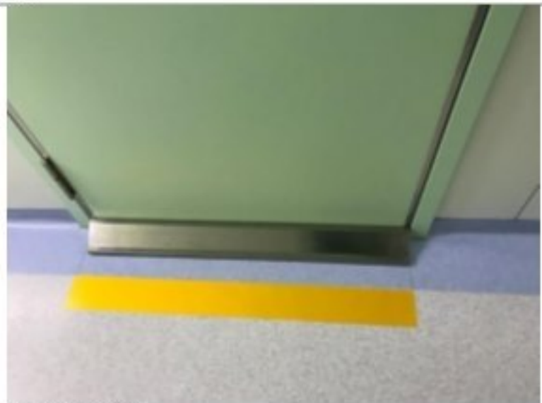
防护门下方设置的防泄露铅板
