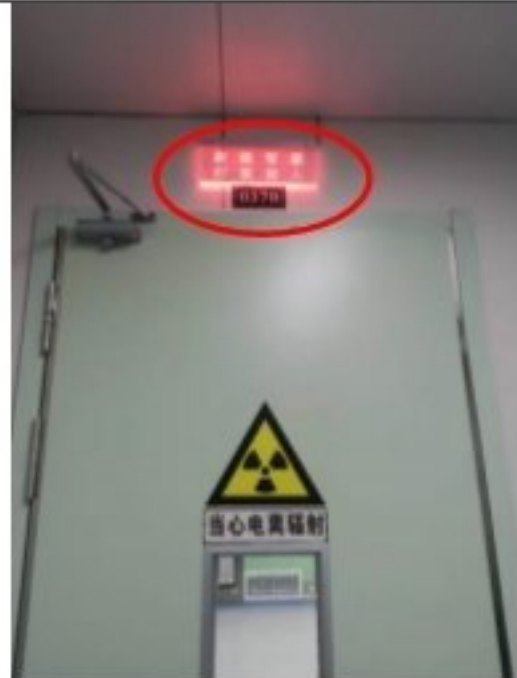
防护门 2 的工作状态指示灯和警告标识
